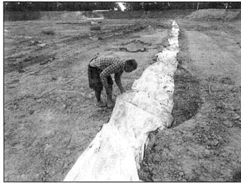
รูปแก้ไขแผ่นจีโอเท็กซ์ไทล์ และงานฝังกลบชายแผ่น HDPE
