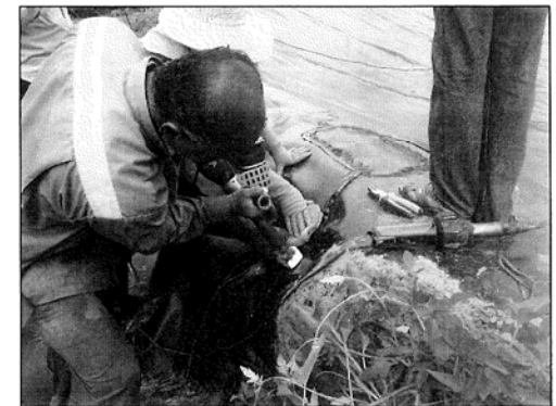
รูปแก้ไขแผ่นจีโอเท็กซ์ไทล์ และงานฝังกลบชายแผ่น HDPE
